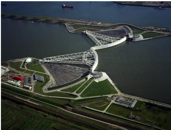
Maeslant Barrier, Rotterdam.
